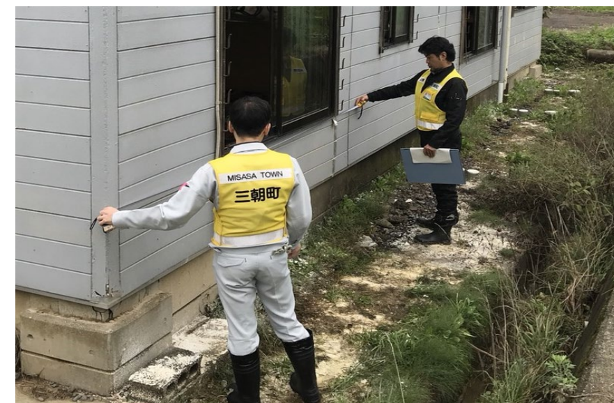
建物被害認定調査 (長野県飯山市)
