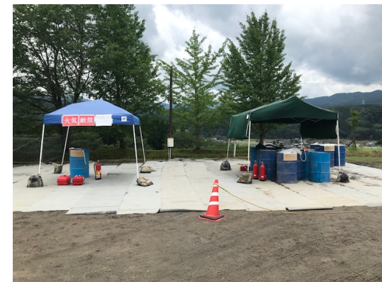
現場の様子(さくらドーム駐車場内)
