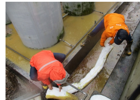
流出した油の回収作業の様子
