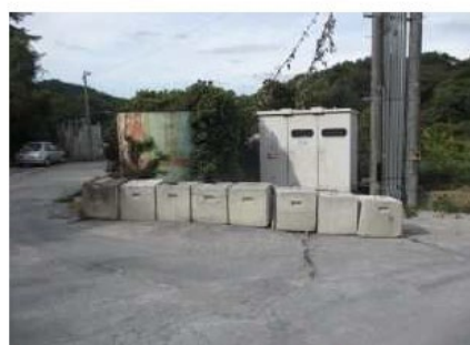
キュービクル前にブロックを設置 (土砂崩れ対策)
