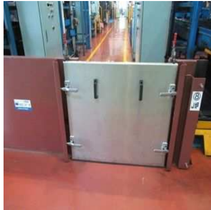
熱処理設備周り（鉄壁開口部のパネル）
