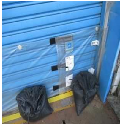
重量シャッター（止水シート）拡大
