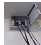
高い位置への配電盤設置
