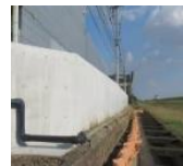
壁による敷地外への流出防止
