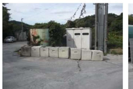
キュービクル前にブロックを設置（土砂崩れ対策）
