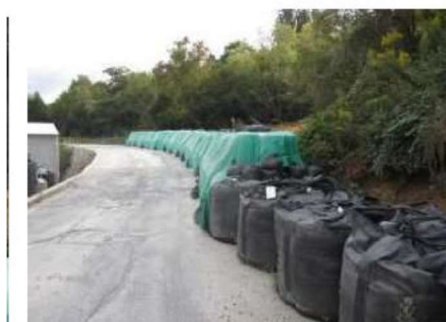
敷地境界に土嚢を設置
