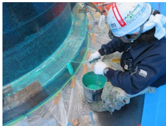
写真-7.4 レジン塗布状況（上塗り）
