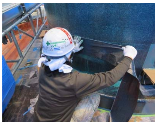
写真-7.3 CFRP シート貼付（鉛直方向・水平方向）
