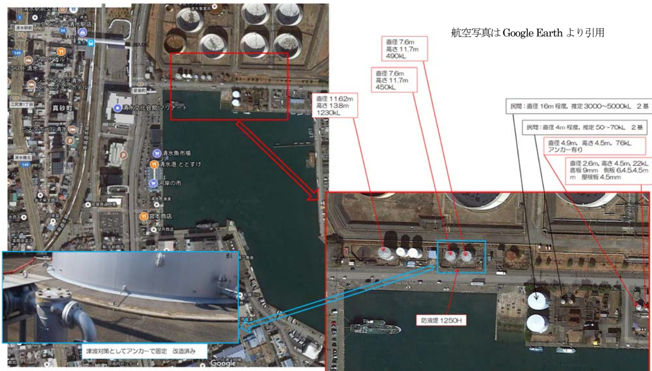
写真-2.1 清水漁港におけるタンクの敷設状況
