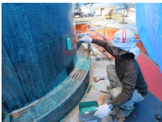
写真-7.2 レジン塗布状況（下塗り）
