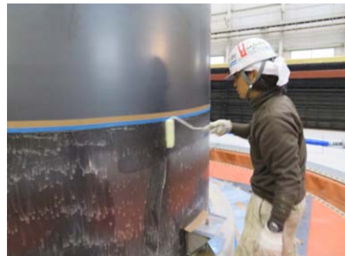
写真-7.1 プライマー塗布状況
