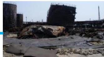
上空写真右上にあった津波により倒壊して燃えたアスファルトタンク
