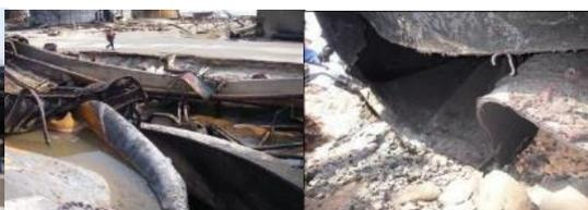
防油堤近傍が洗掘され、防油堤が壊れている(中央)。底板と側板は、長さ2.4mにわたって破断している(右)。
