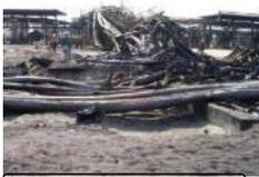
出荷場付近の配管ラックの配管も焼損している。
