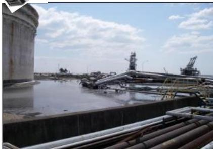
タンクが健全であっても、津波により配管が折れ曲がって、危険物が流出している(上空写真左側の台形枠内でも配管が折れ曲がっている)。
