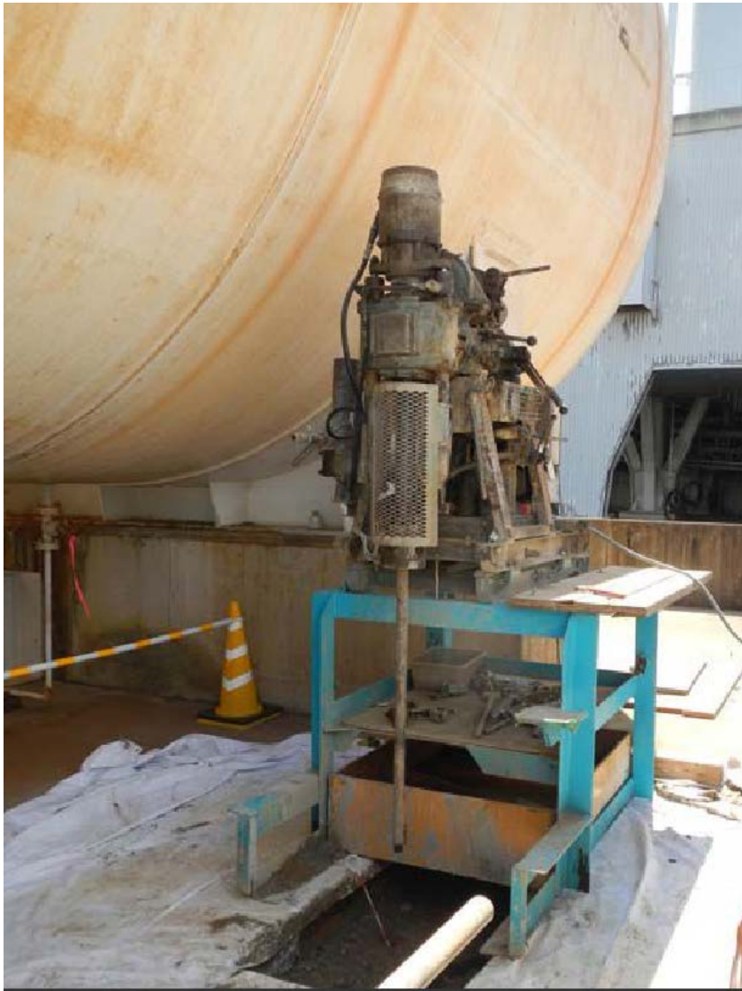
グラウンドアンカー削孔
