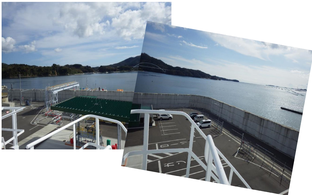
防潮堤（タンク屋根上から撮影）
