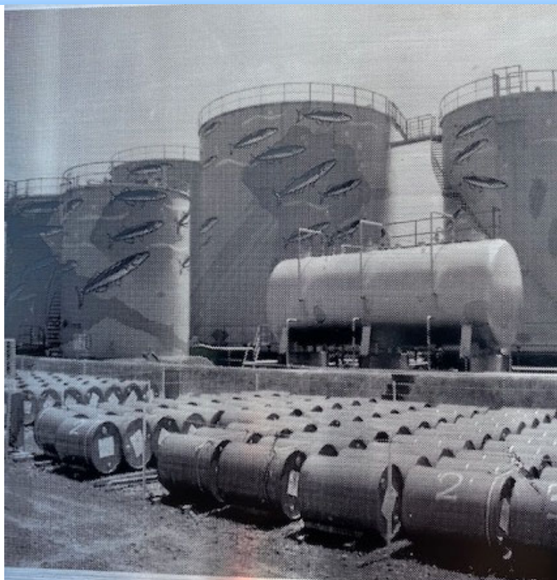
震災前の油槽所 （横置円筒型タンク以外は全て津波により流出）
