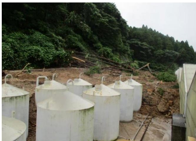
図 2-20 タンクと流れ込んだ土砂
