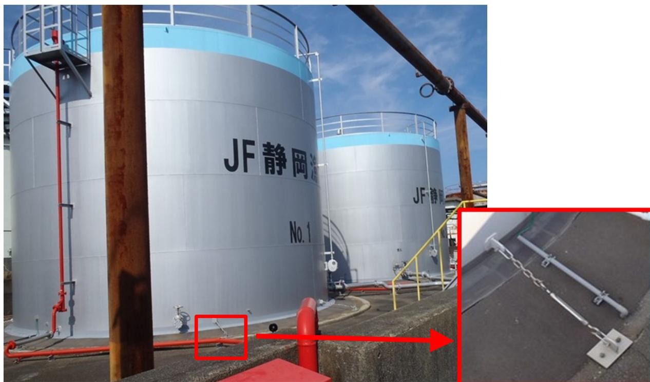
図2-31 ターンバックルを用いた津波対策施工タンク
