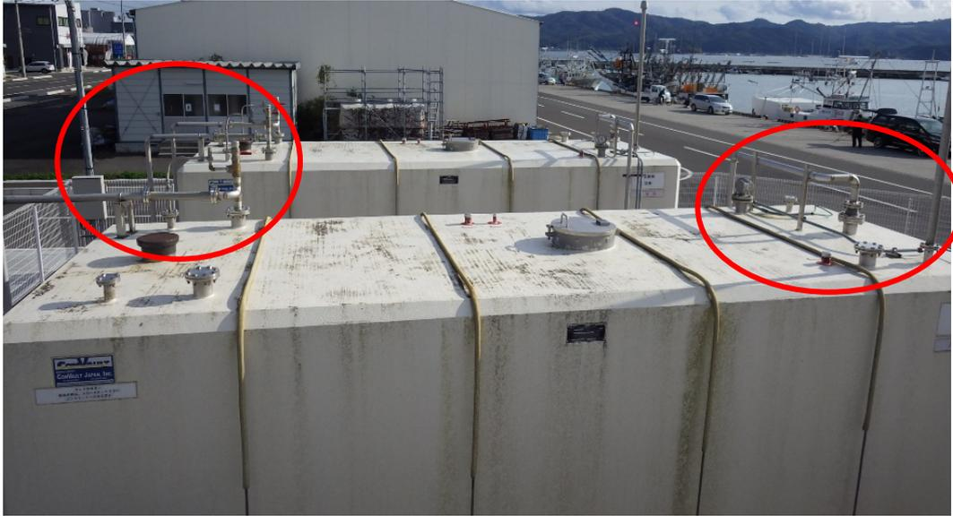
図 2-29 コンクリート被覆型タンク屋根のノズル部(配管取合部)
