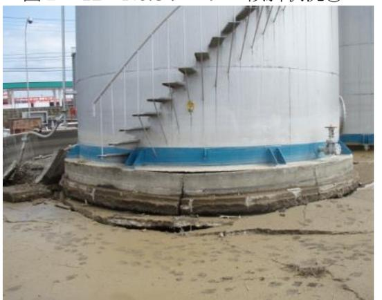
図 2-14 No. 3タンクの地盤面損壊状況①
