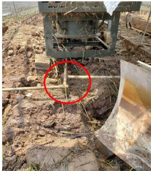
図 2-19 破損した配管
