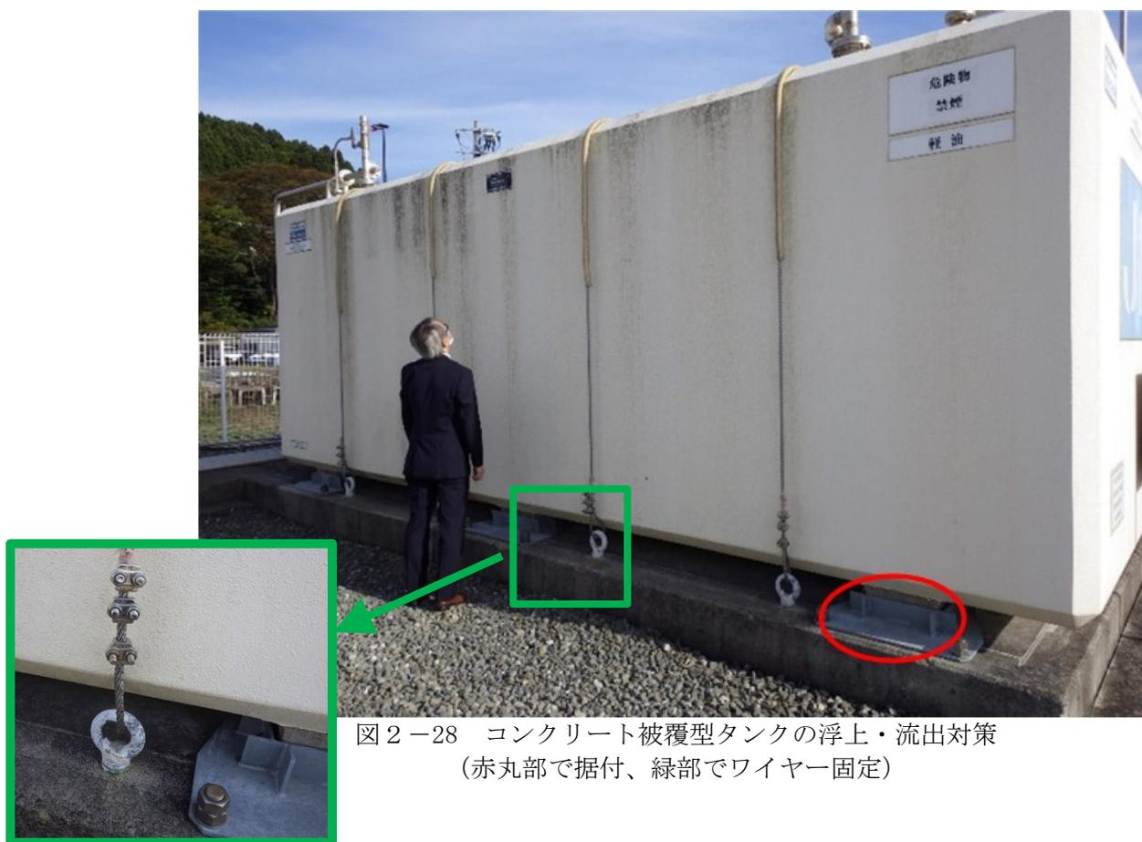
図 2-28 コンクリート被覆型タンクの浮上・流出対策
