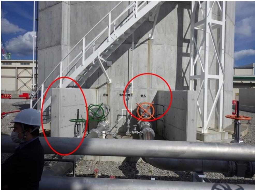
図 2-24 タンクノズル部の防護壁と緊急遮断弁
