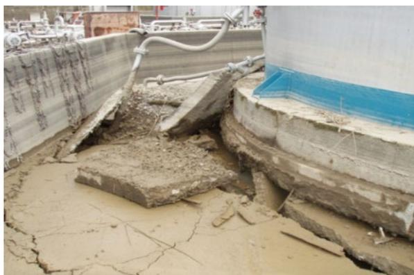
図 2-15 No. 3タンクの地盤面損壊状況②
