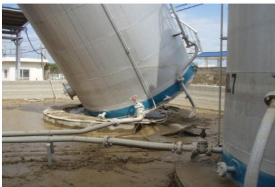
図 2-12 No.8 タンクの傾斜状況①
