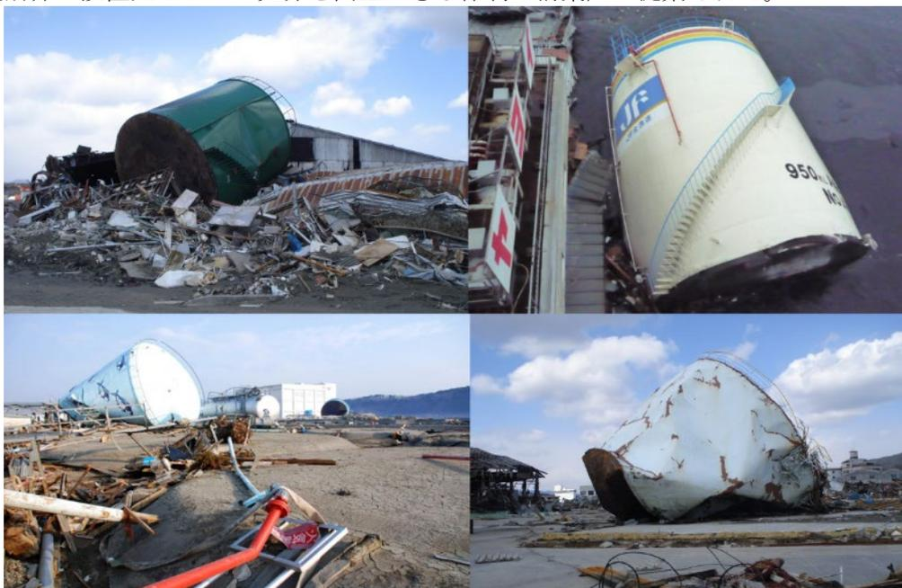
図2-2 宮城県気仙沼市における屋外タンク貯蔵所の被害
