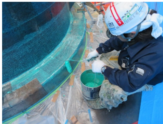
図1-6 エポキシ樹脂塗布状況（上塗り）
