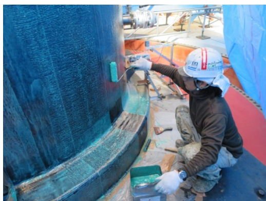
図 1-4 エポキシ樹脂塗布状況 (下塗り)
