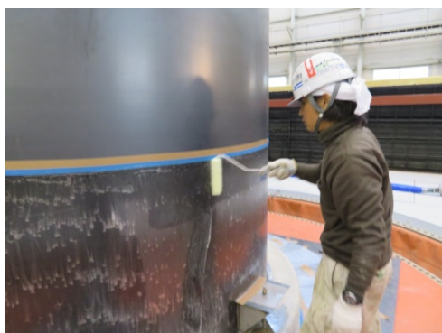
図 1-2 プライマー塗布状況
