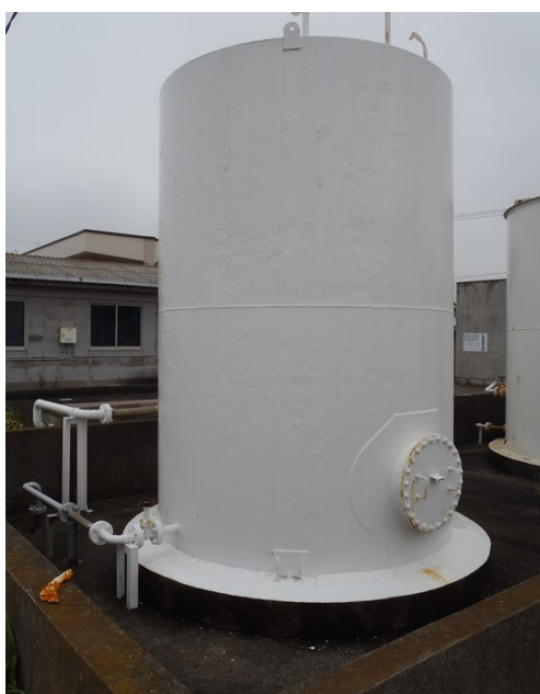
図3-17 小型屋外貯蔵タンクの例
