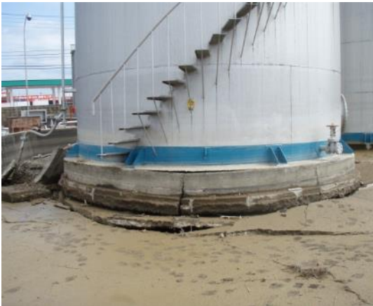
図 2-14 No.3 タンクの地盤面損壊状況①
