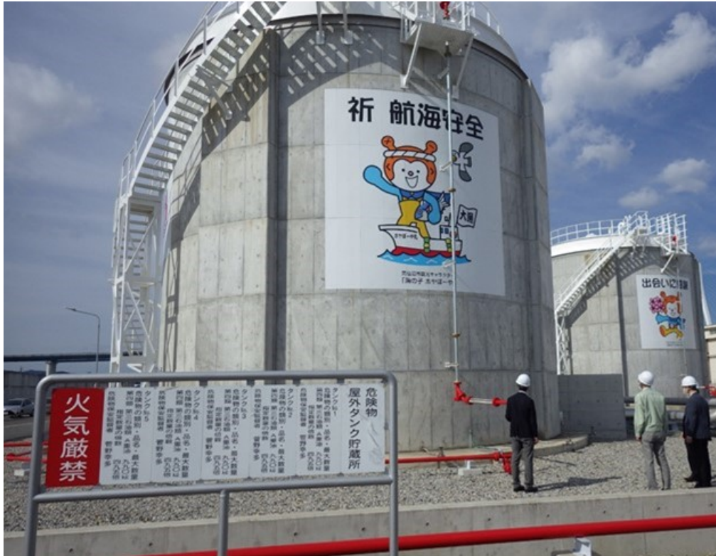
図 2-22 気仙沼市 PC工法 津波対応型 屋外貯蔵タンク
