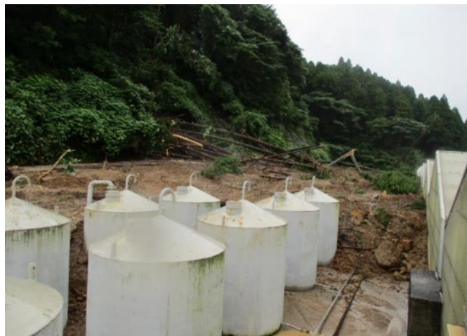
図 2-20 タンクと流れ込んだ土砂
