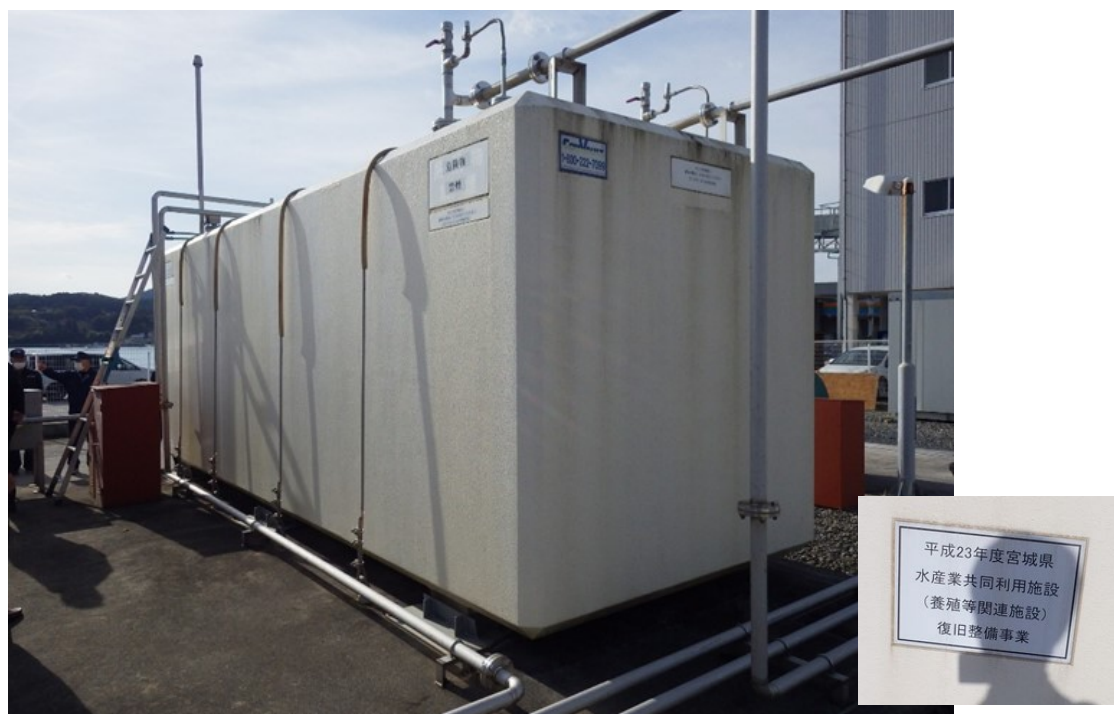
図2-26 志津川漁港 コンクリート被覆型タンク
