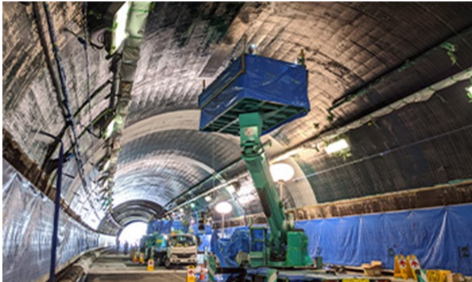
図3-16 トンネル内施工の例 (メーカーホームページ https://www.tbm.toray/business/carbon/ より)
