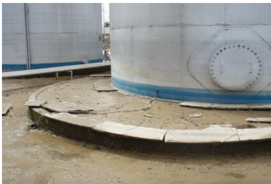
図 2-10 No.4 タンクの横ずれ状況①
