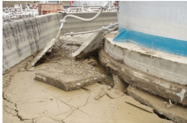
図 2-15 No.3 タンクの地盤面損壊状況②
