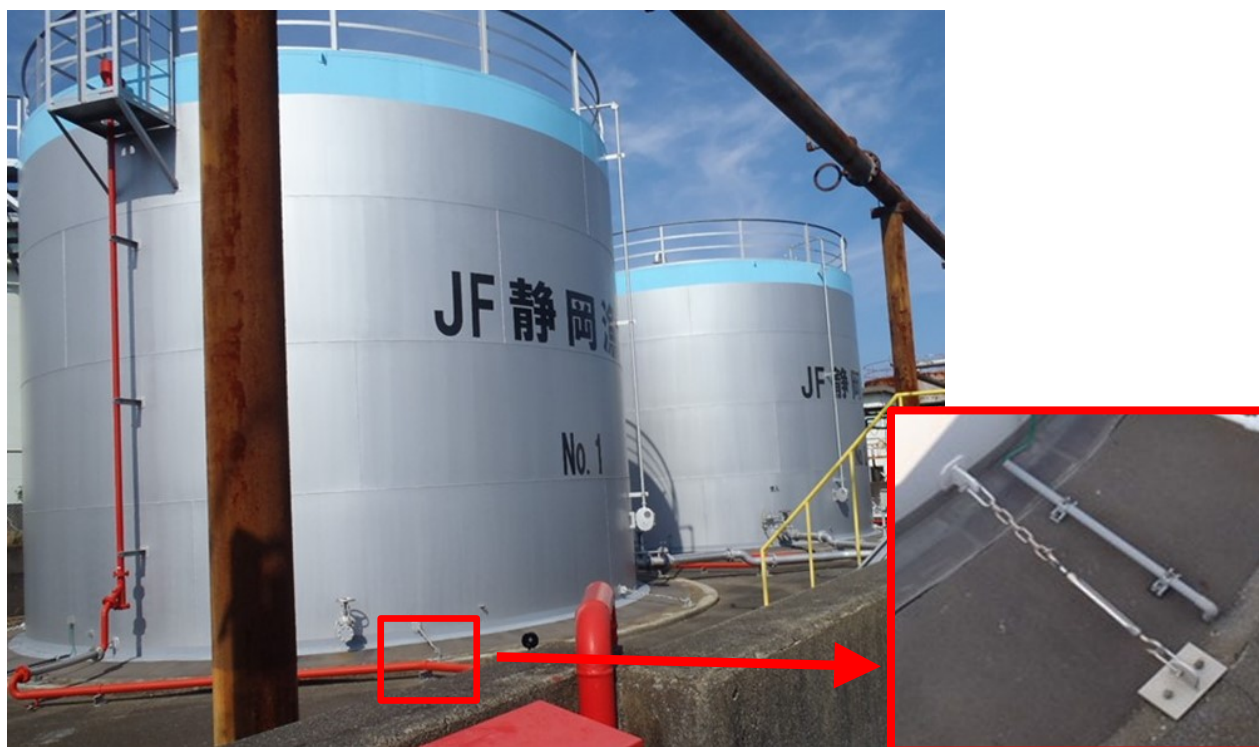
図2-31 ターンバックルを用いた津波対策施工タンク
