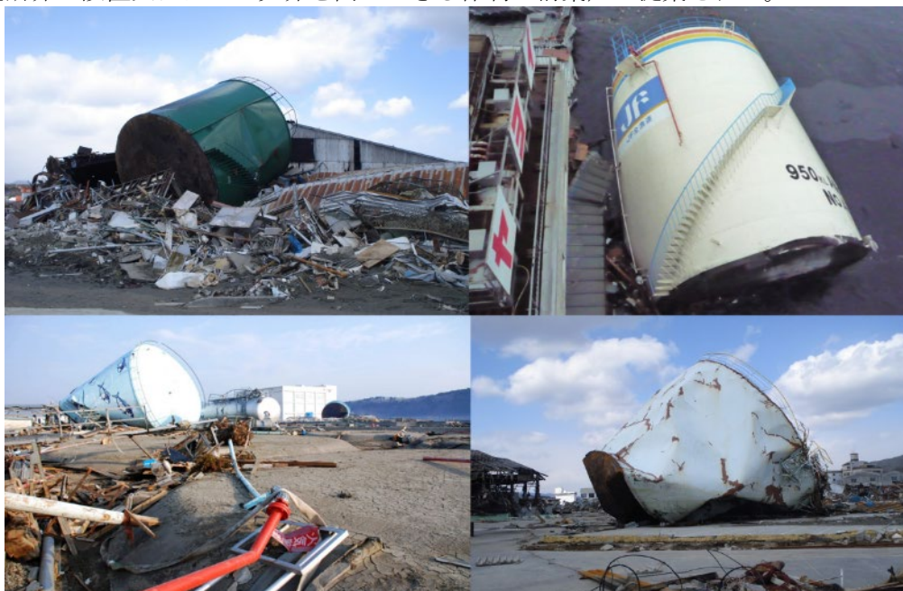
図2-2 宮城県気仙沼市における屋外タンク貯蔵所の被害
