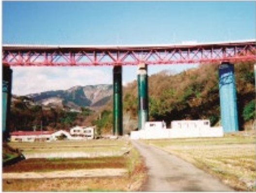
図3-15 橋梁部，煙突施工の例 (メーカーホームページ http://www.mp-infratec.co.jp より)
