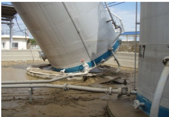
図 2-10 No.4 タンクの横ずれ状況①
