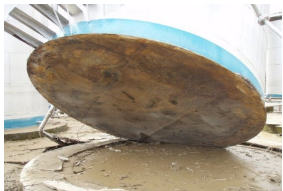
図 2-11 No.4 タンクの横ずれ状況②
