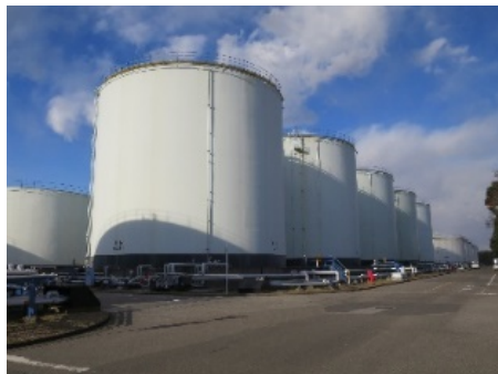
実証対象となるタンク
