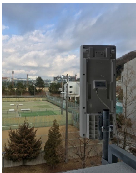
写真 11 屋外寒暖を東向きに設置
