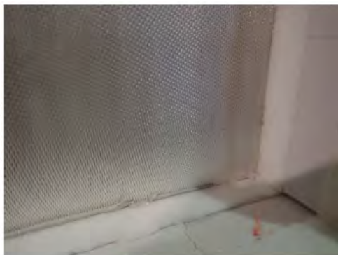
写真 6 試験後の耐火クロスの状況 (試験体記号 1, 加熱側近影)
