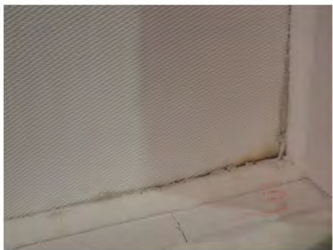
写真10 試験後の耐火クロスの状況 (試験体記号3,加熱側近影)
