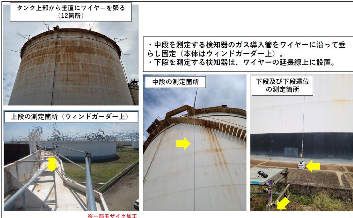
写真1-3 ガス検知器設置状況 (フローティングルーフタンク)
