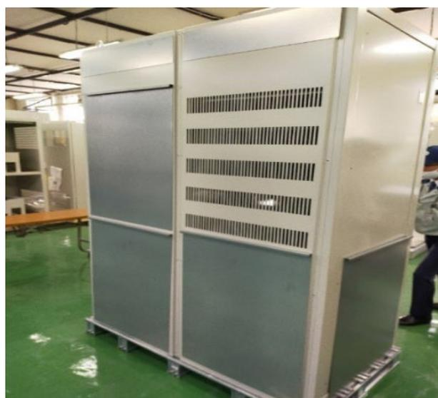
図3-7 換気口に鋼板を貼り付け一時貯蔵
