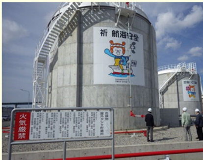
宮城県気仙沼市に設置されたPC工法タンクの調査
