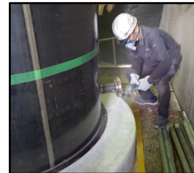
基礎コンクリートのケレン
