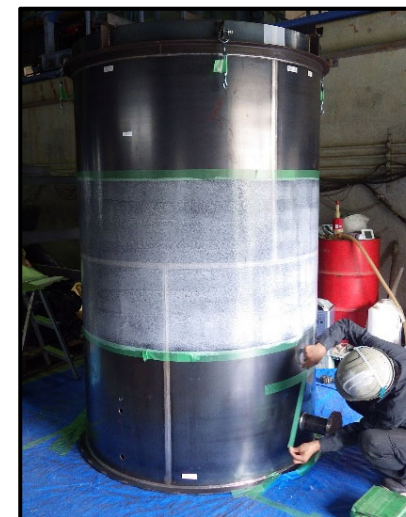
プライマー塗布後のタンク
