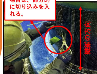
炭素繊維シート貼付け（一層目）
