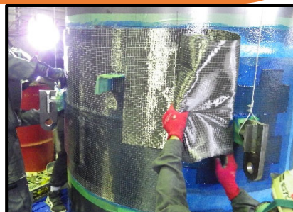
アイプレート部の作業
