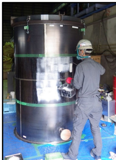
ローラーによるプライマー塗布
