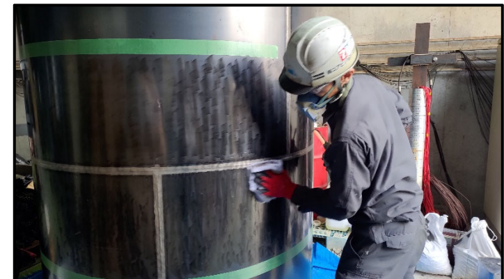
アセトンを染み込ませたウェスによる脱脂
