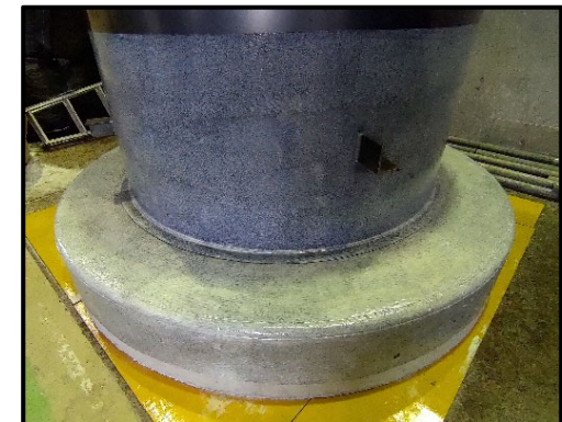
プライマー塗布後のタンク
