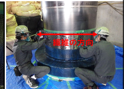
炭素繊維シート貼付け（二層目）
