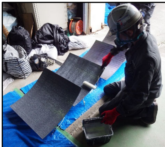
アイプレート裏側へのプライマー塗布
