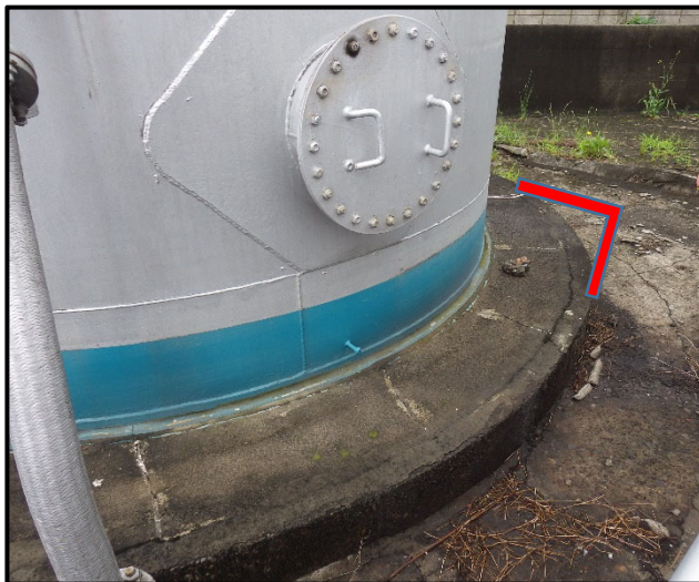
基礎コンクリートの角部
