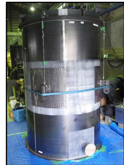
アイプレート吊下げと 固定バンド養生
