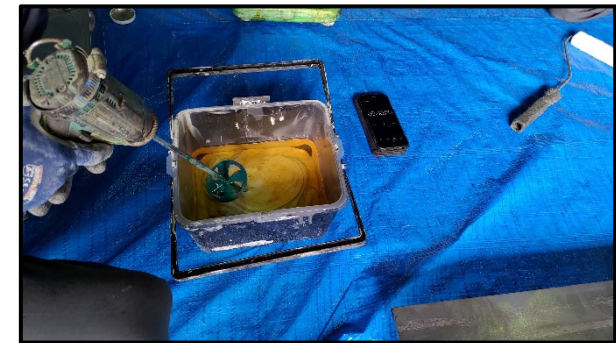
攪拌調合状況
