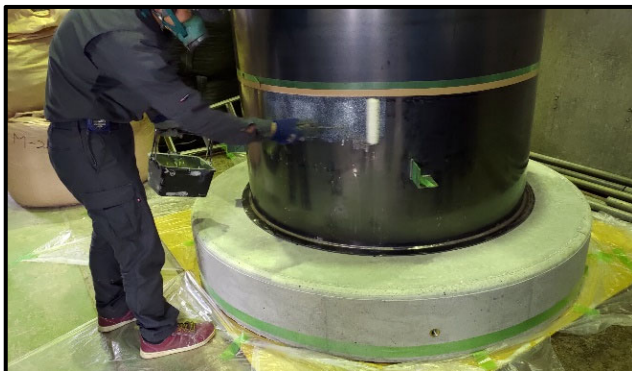
ローラーによるプライマー塗布
