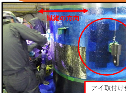
炭素繊維シート貼付け
