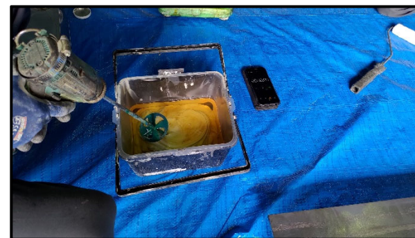
攪拌調合状況
