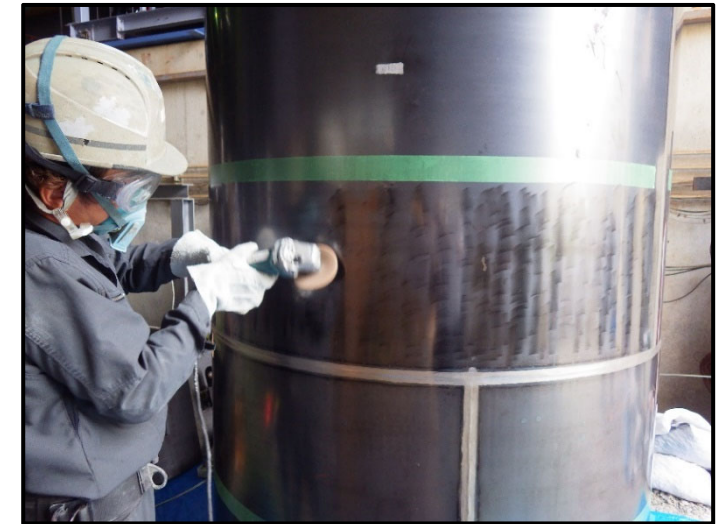
タンク鋼板部のケレン
