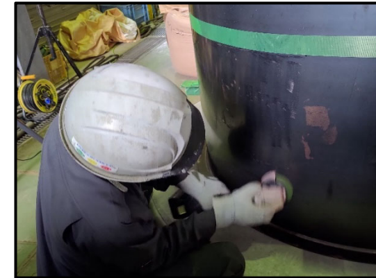
タンク鋼板部のケレン
