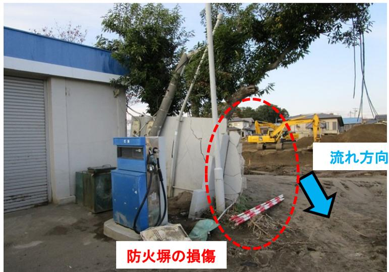
図2-46 N給油所 防火塼の損傷1
