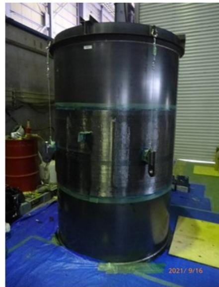
図4-14 CFRP貼付け
