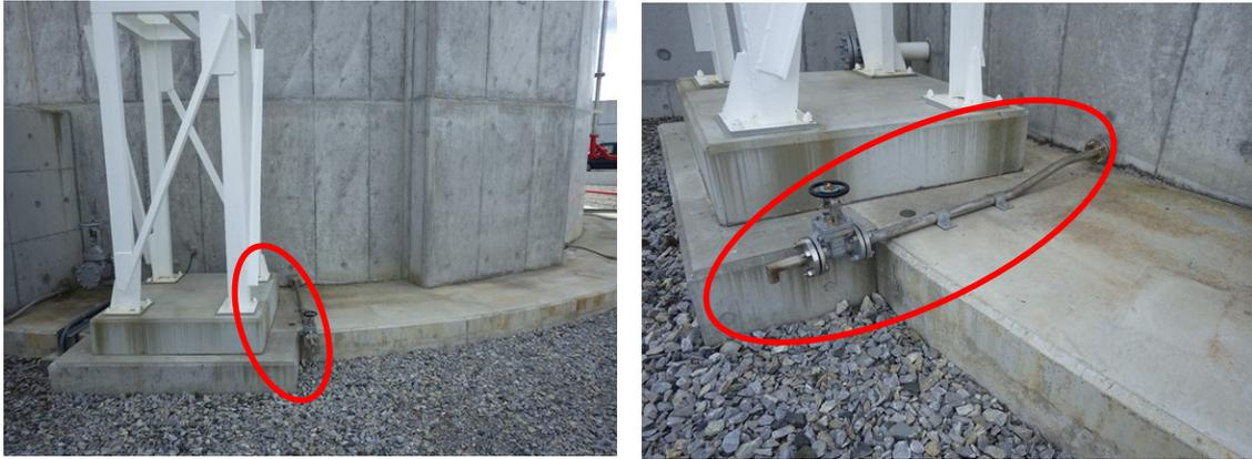
図 2-14 タンク本体とPC壁間の排水管とバルブ
