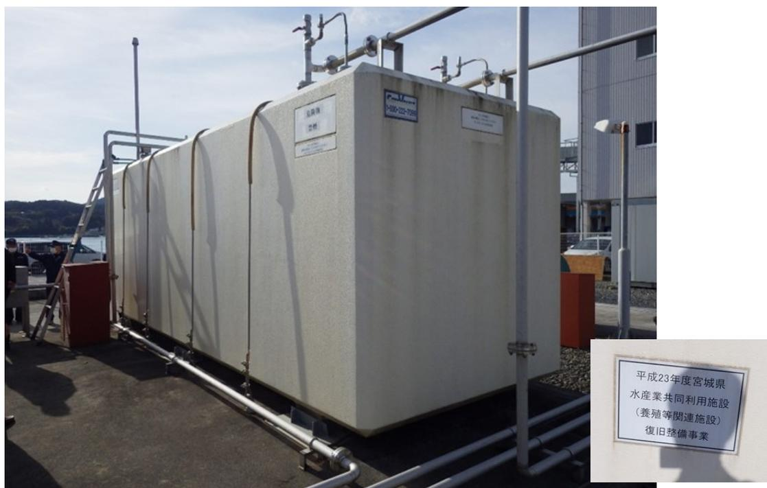
図2-16 志津川漁港 コンクリート被覆型タンク
