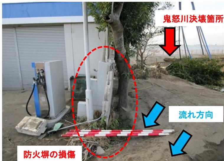
図2-47 N給油所 防火塼の損傷2
