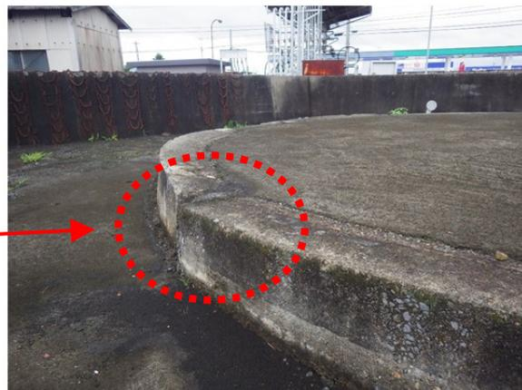
図 2-35 No. 3 タンク リング基礎割れ部拡大
