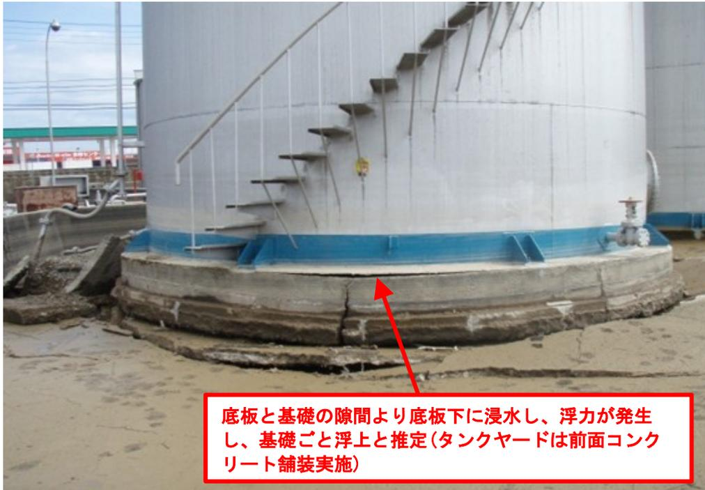
図 2-36 No. 3 タンク 被害状況 (図 2-14 に加筆)
