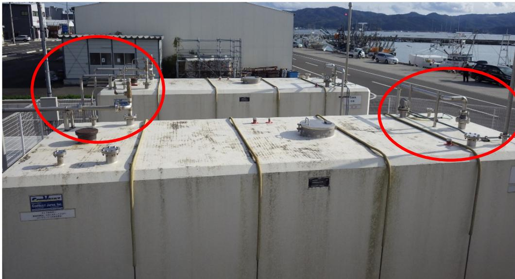
図 2-19 コンクリート被覆型タンク屋根のノズル部(配管取合部)
