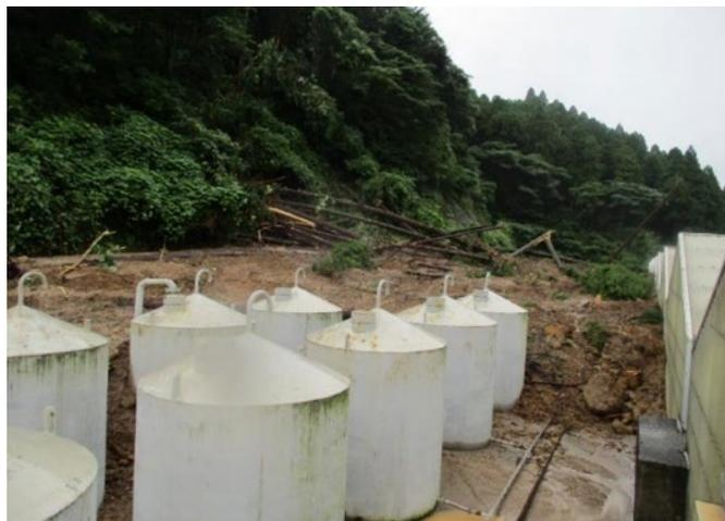
図 2-10 タンクと流れ込んだ土砂
