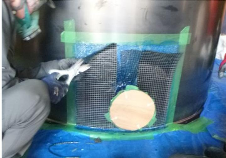
図 4-21 ノズル周囲の井桁状の補強
