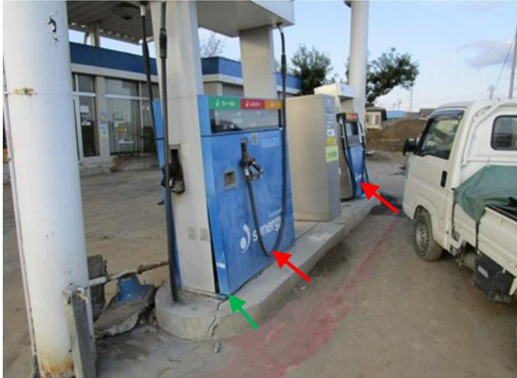
図2-45 N給油所 計量器の傾き（赤矢印部）と基礎の割れ（緑矢印部）
