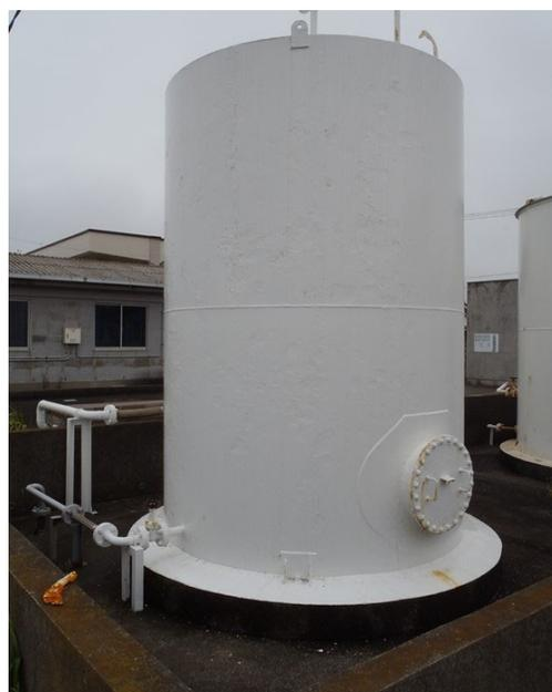
図 3 - 18 小型屋外貯蔵タンクの例
