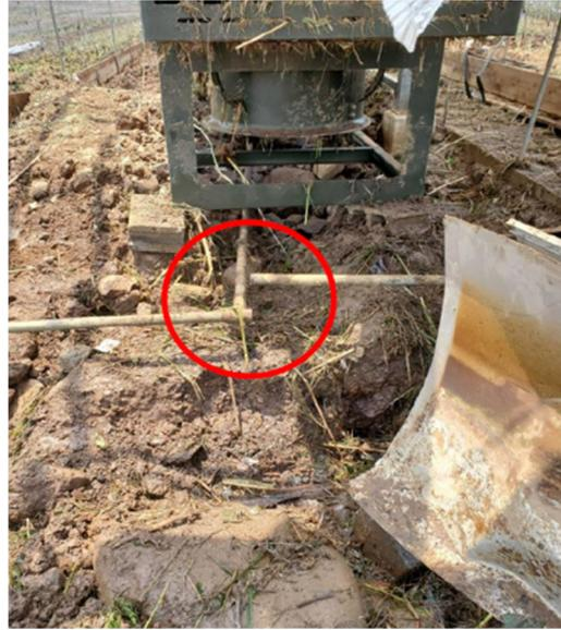
図 2-9 破損した配管
