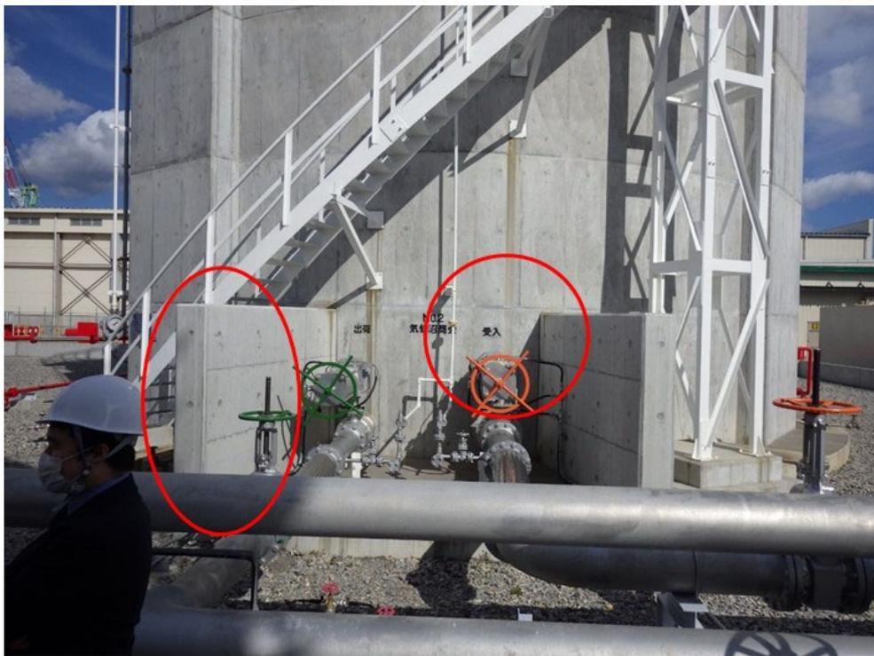
図 2-15 タンクノズル部の防護壁と緊急遮断弁
