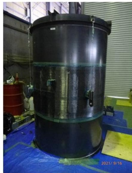
図3-14 CFRP貼付け
