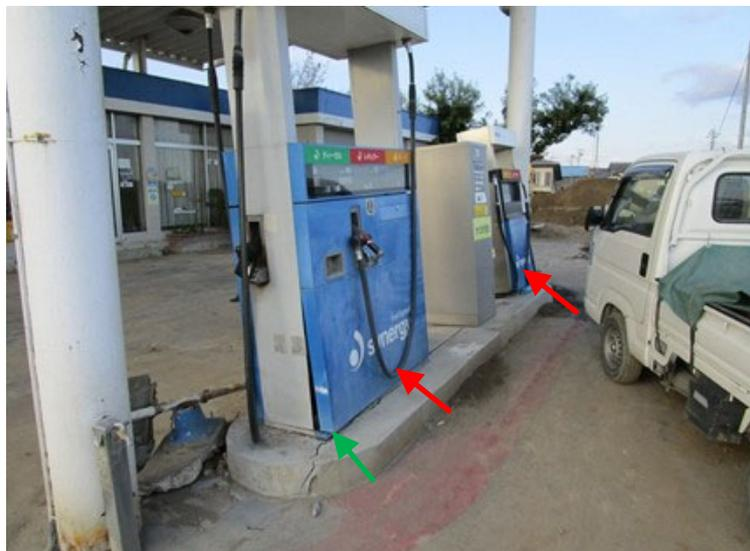
図 2 - 40 N給油所 計量器の傾き（赤矢印部）と基礎の割れ（緑矢印部）
