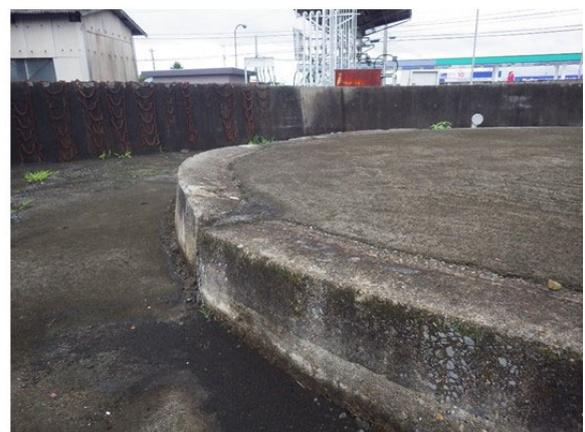
図 2-34 No. 3 タンク リング基礎割れ部拡大
