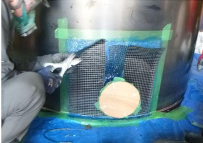
図 3-21 ノズル周囲の井桁状の補強
