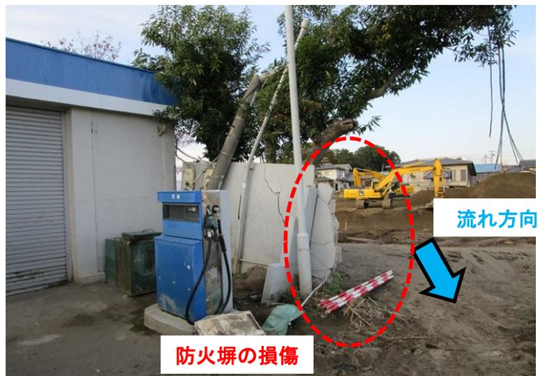
図 2 - 41 N給油所 防火塀の損傷 1
