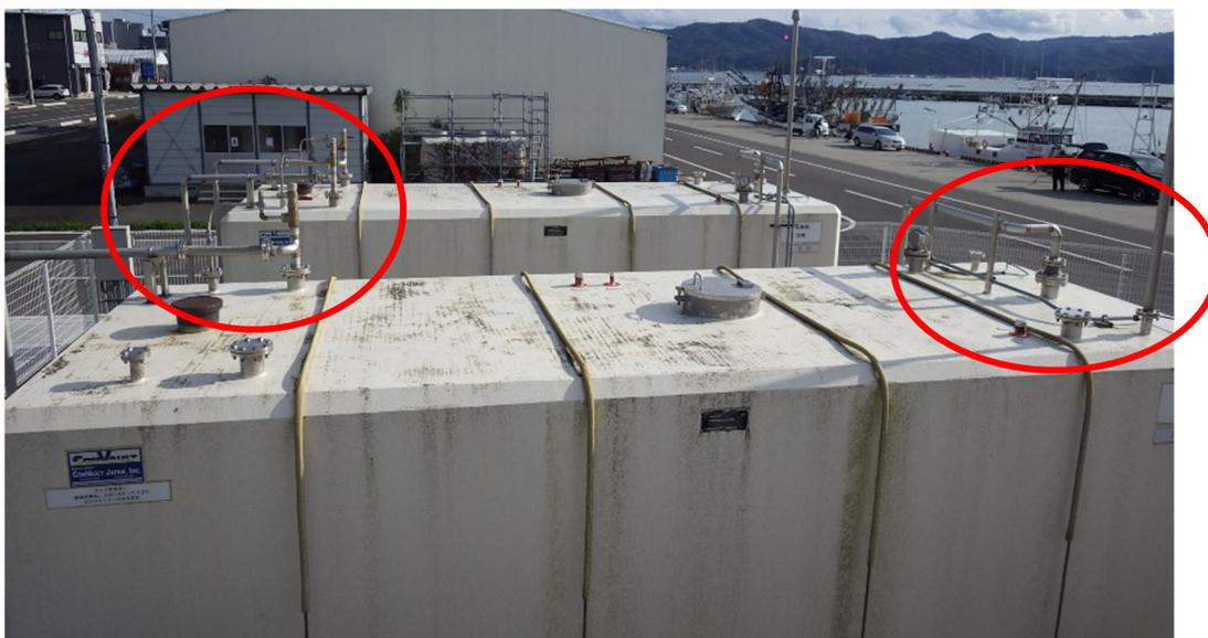
図 2-19 コンクリート被覆型タンク屋根のノズル部(配管取合部)
