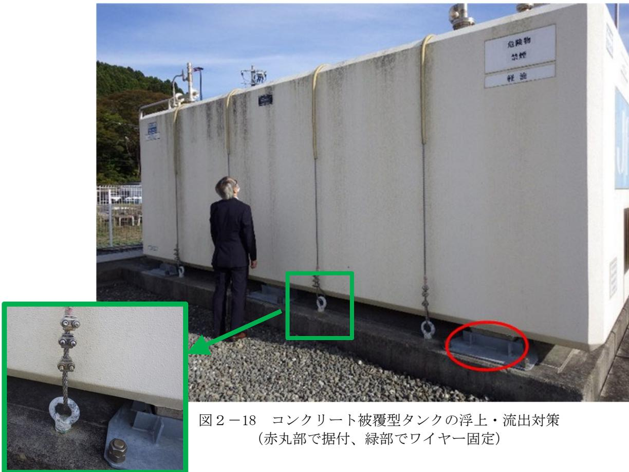
図 2-18 コンクリート被覆型タンクの浮上・流出対策 (赤丸部で据付、緑部でワイヤー固定)
