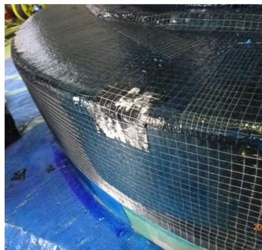
図3-8 不具合箇所の補修方法確認
