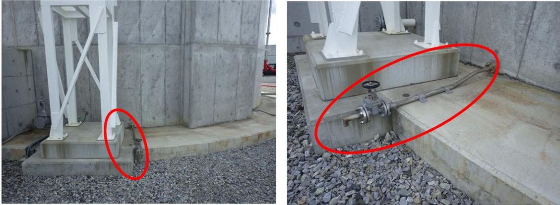
図 2-14 タンクと PC 壁間の排水管とバルブ
