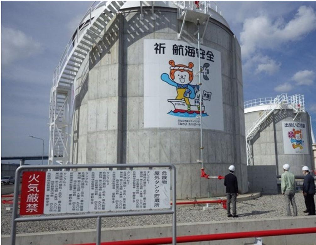
図 2-12 気仙沼市 P C工法 津波対応型準特定屋外貯蔵タンク
