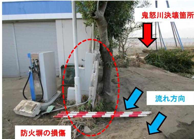
図 2-42 N給油所 防火塀の損傷 2
