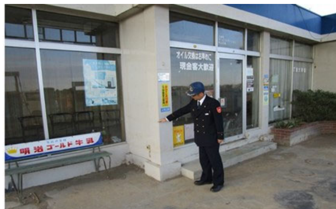
図2-38 N給油所での浸水深
