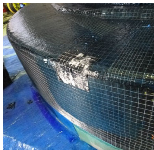
図3-8 不具合箇所の補修方法確認
