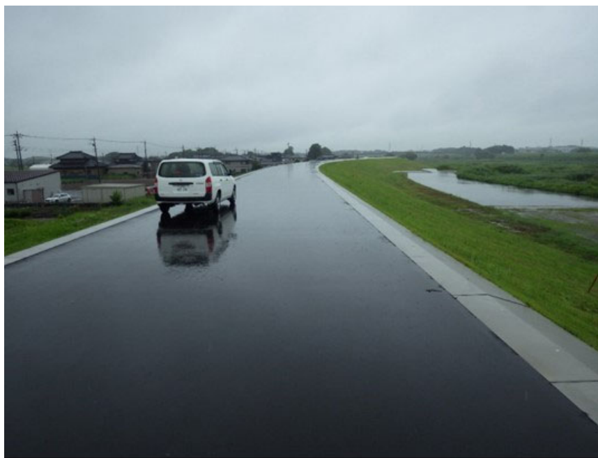
図 2-25 鬼怒川堤防決壊箇所の現在の状況 2
