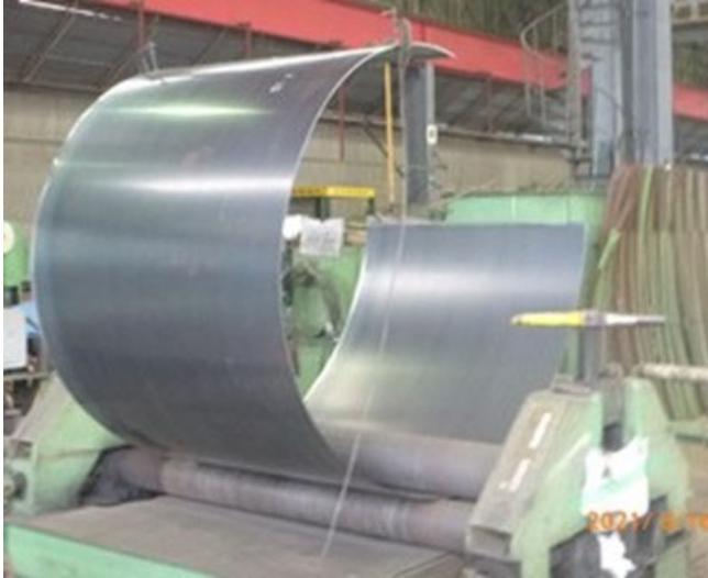
図3-25 タンク側板の板曲げ
