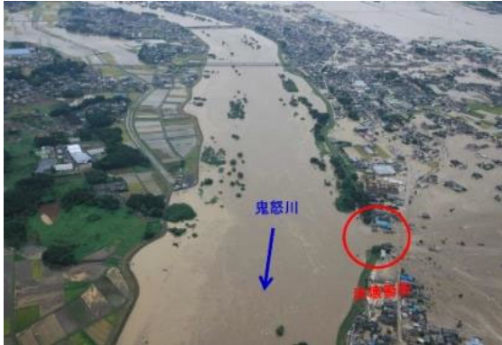
図 2－4 鬼怒川堤防決壊現場
