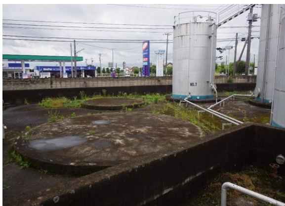
図 2-31 No. 4, No. 8 タンク現状 (タンク跡)
