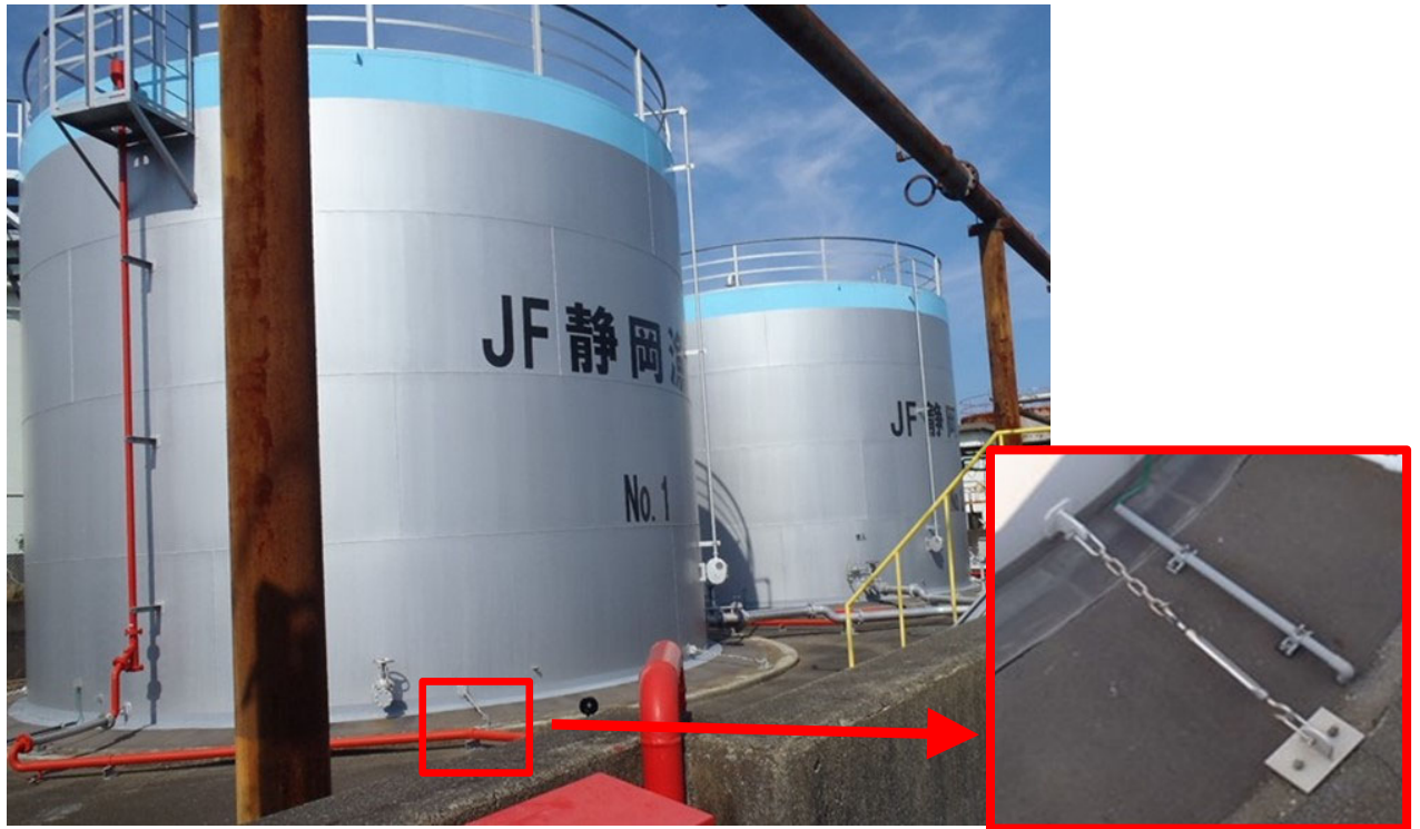
図2-21 ターンバックルを用いた津波対策施工タンク
