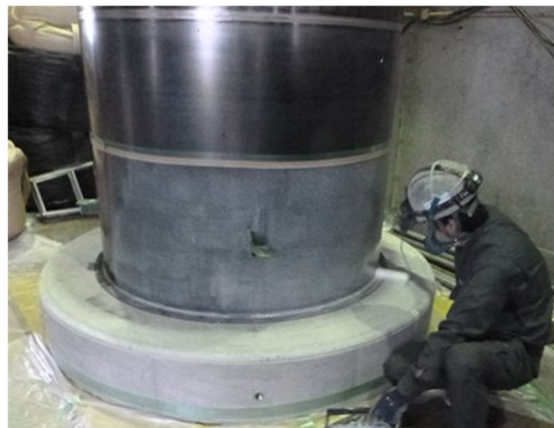
図3-4 プライマー塗布
