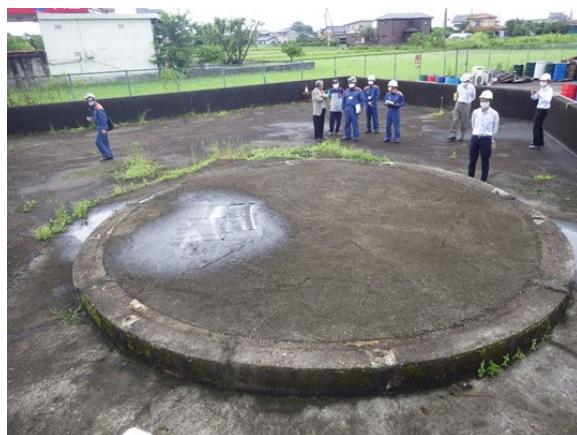
図 2-33 No. 3 タンク リング基礎
