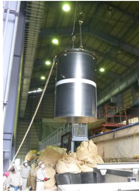
図3-26 タンク搬入状況
