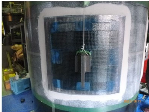
図3-13 アイプレートの設置と不陸修正
