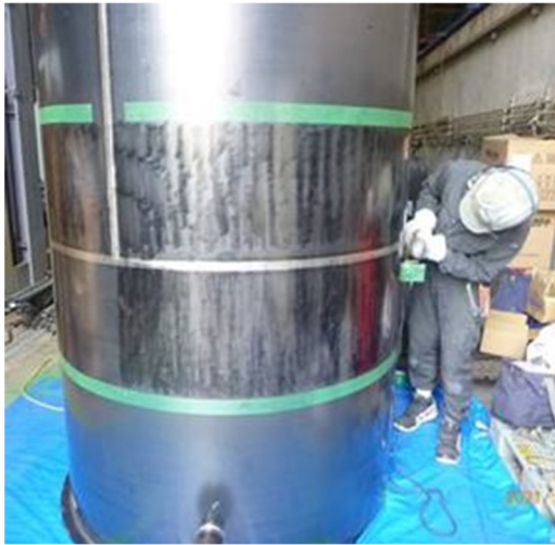
図3-11 側板部の目粗し
