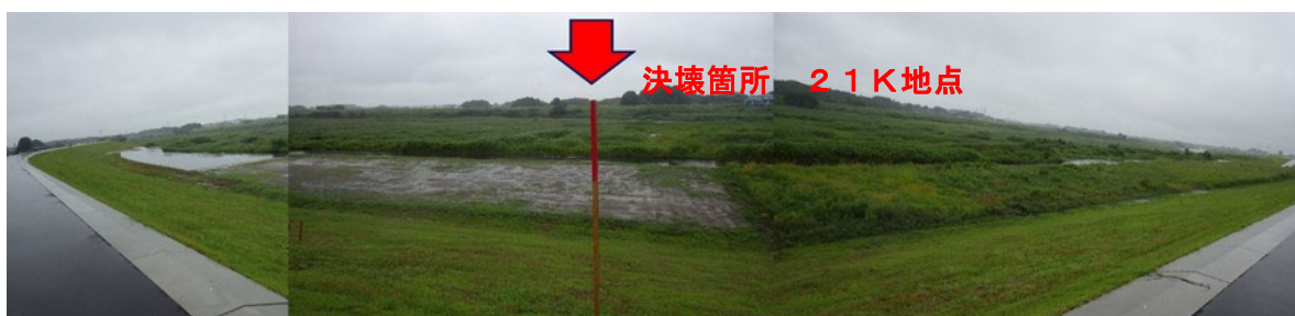
図 2-24 鬼怒川堤防決壊箇所の現在の状況 1
