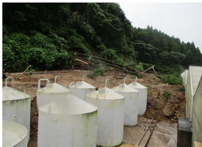
図 2-10 タンクと流れ込んだ土砂
