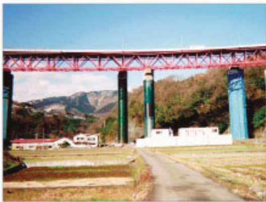
図3-17 橋梁部、煙突施工の例
