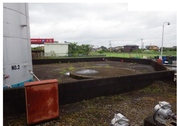
図 2-32 No. 3 タンク現状 (タンク跡)
