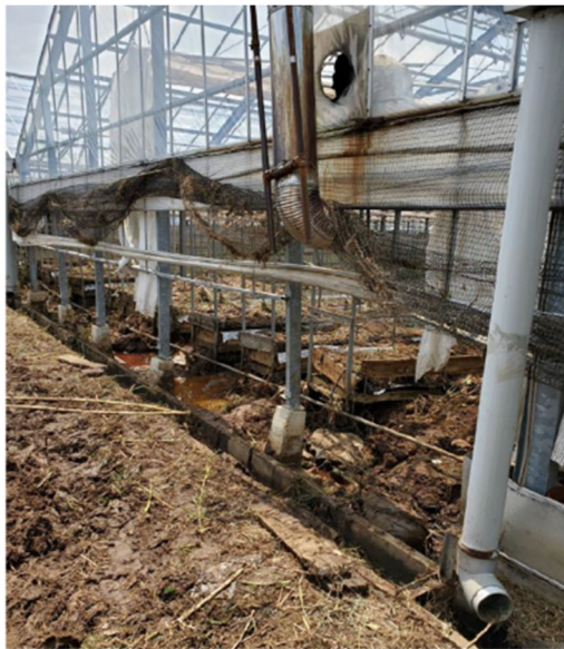
図 2-8 ビニールハウス
