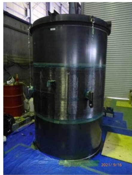
図3-14 CFRP貼付け
