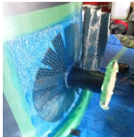
図3-20 ノズル周方向への貼付け
