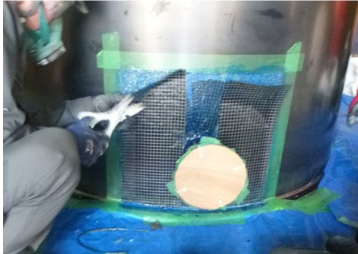
図 3-21 ノズル周囲の井桁状の補強
