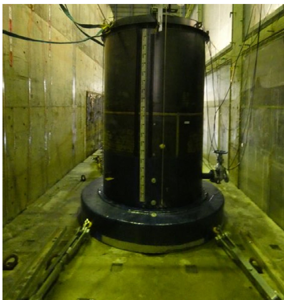
(1) 対策工法1_全体
