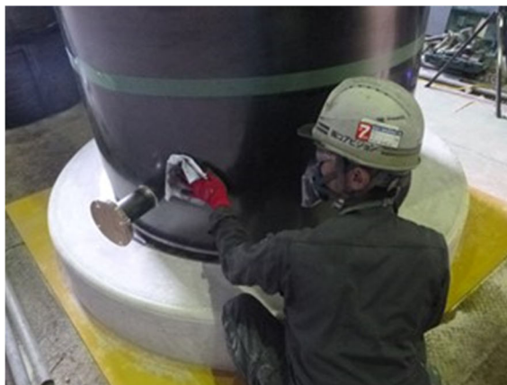
図3-3 有機溶剤による脱脂
