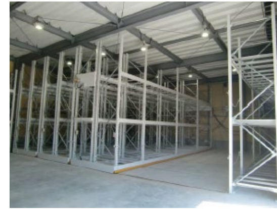
④屋内貯蔵所の 移動式架台 設置の際の 留意事項を検討
