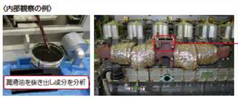
送給機を取り外し、排気管内部の未燃燃料や燃焼残渣物の異常な堆積の有無を目視点検
