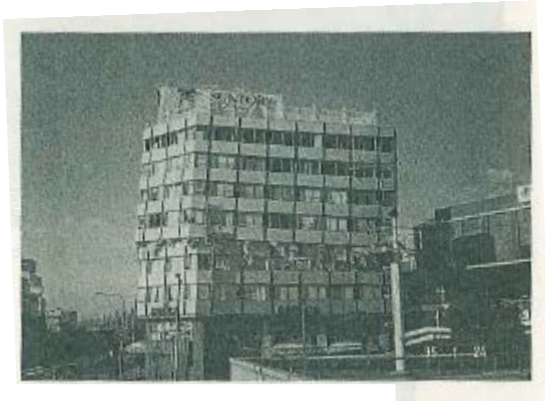
写真1 9層建物：5層崩壊
