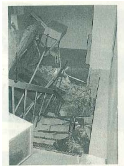
写真7 階段1, 2階部分の破損状況
