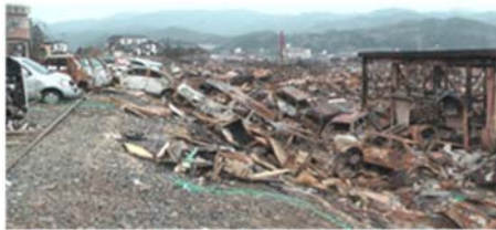
写真B 鹿折地区火災線路上の焼損状況
