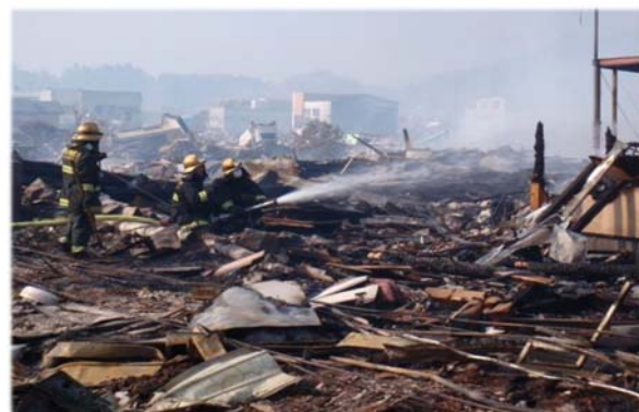
消防隊による消火活動①
