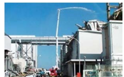
緊急消防援助隊による3号機への 放水(東京消防庁HPより)
