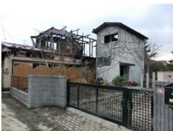
写真D 建物火災の状況
