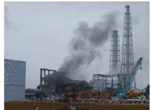
東京電力(株)福島第一原子力発電所3号機 (東京電力HP(3月21日撮影)より)
