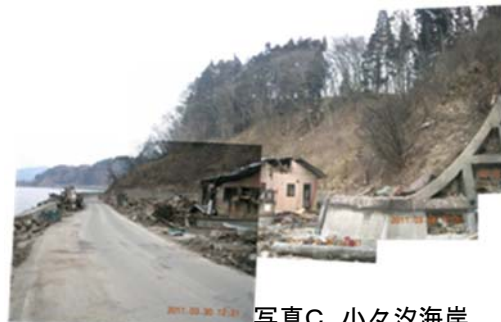
写真C 小々汐海岸の延焼状況
