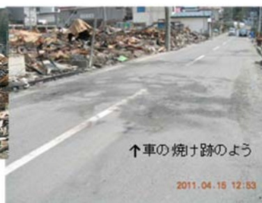
写真C 道路上の焼損跡の状況
