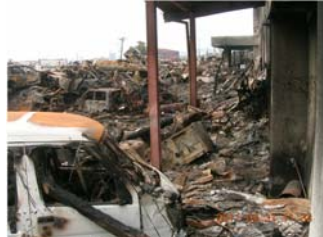
写真B 門脇小学校校舎1階付近の状況
