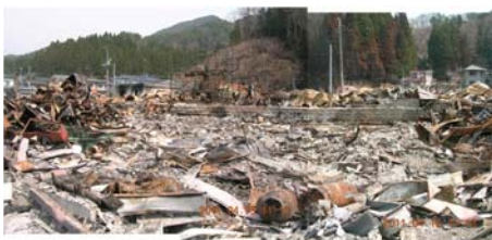
海側の焼けどまり道路から延焼地域(山側)を望む
