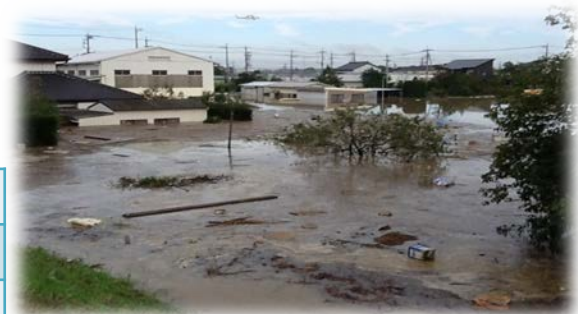
茨城県常総市内の浸水状況
